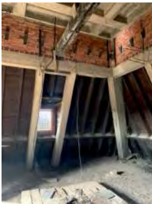
Interior del chapitel.
