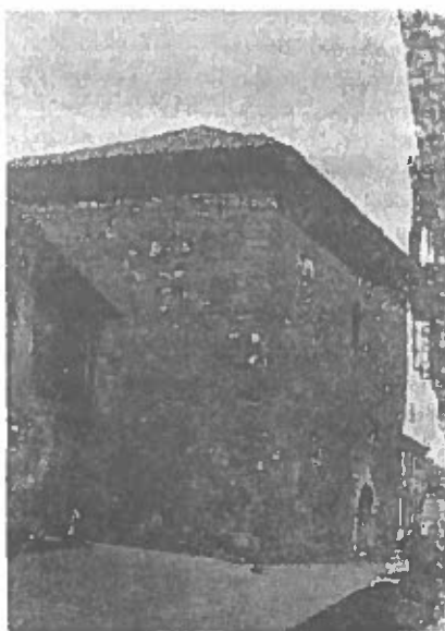
CASA DE LA TORRE
