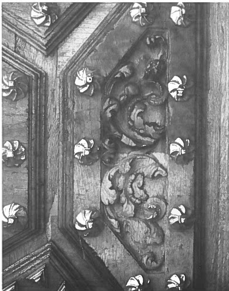
"Detalle de la restauración
