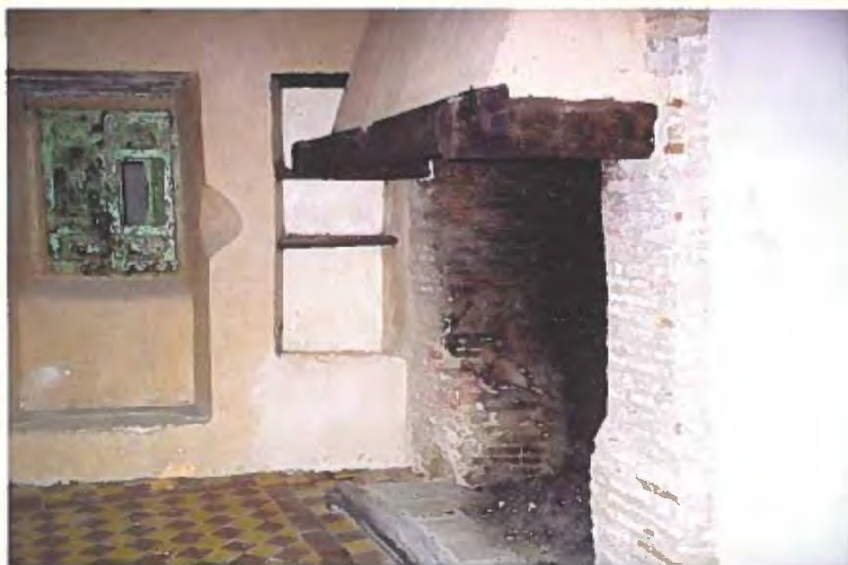
Cocina de la Casa del Sacristán, antes y después de ser restaurada.
